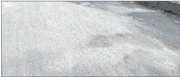
रेवाड़ी। मिनी बाइपास की नई सड़क की निकली रोड़ियां, ब्रास मार्केट की मेन सड़क के गड्डों में जमा पानी।
